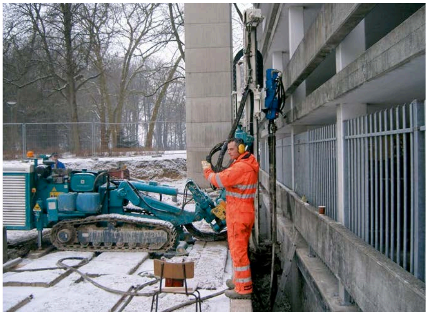
Bohrungen \varnothing 101 mm (4 Zoll) Außenrohre
